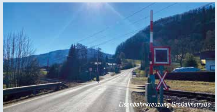
Eisenbahnkreuzung in Eben
