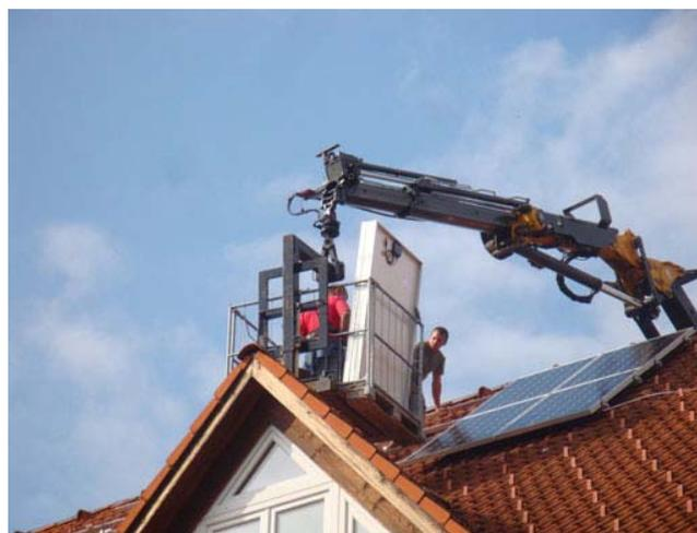
Abbildung 3-2: Installation einer PV-Anlage
